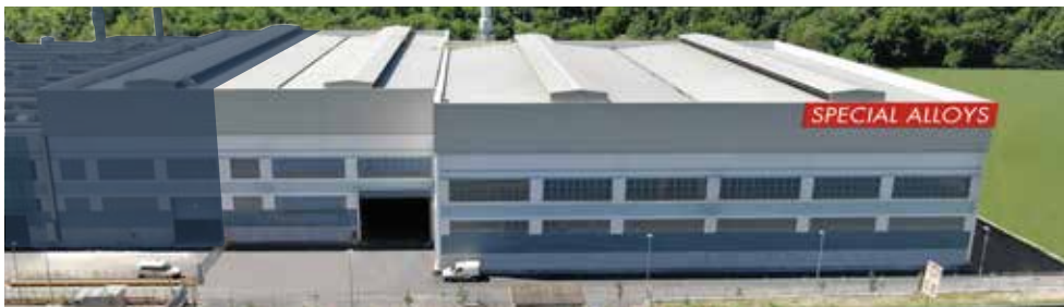
Stabilimento produttivo Special Alloys per la produzione di leghe di alluminio primario da riciclo
