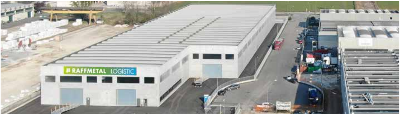
Stabilimento di Nuvolera dedicato allo stoccaggio del prodotto finito
